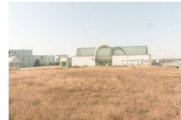
Střecha terminálu, východní část
