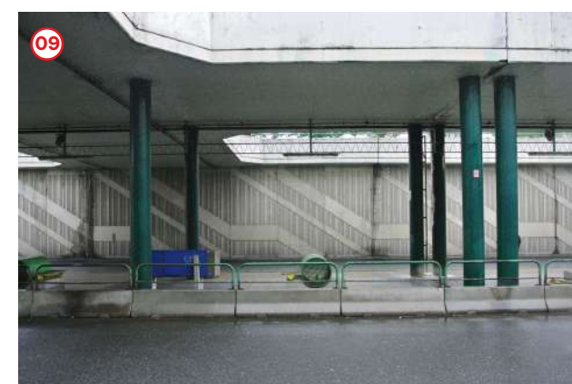
Betonový plot zamezující příčný pohyb mezi nástupišti
