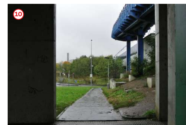
Výstup z podzemního podlaží terminálu bez vert. komunikace
