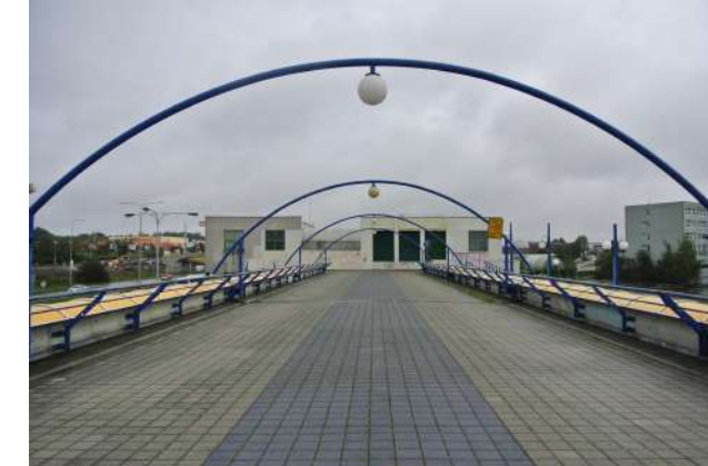
Ukončení promenády na tubusu
