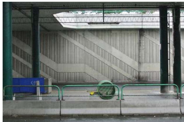
Betonové bariéry zabraňující pohybu mezi nástupišti
