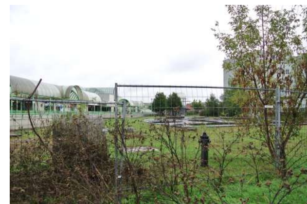
Oplocení nedokončené stavby polyfunkčního domu
