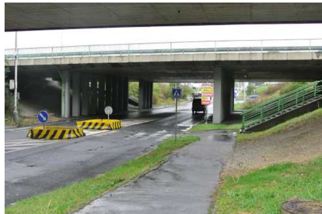
Po schodech mezi ul. Ocelková a cyklostezkou na tubusu
