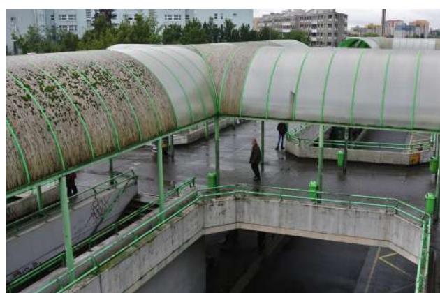
Podhled zastřešující lávky
