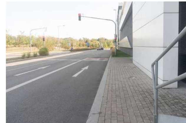
Chybějící chodník a přechod
