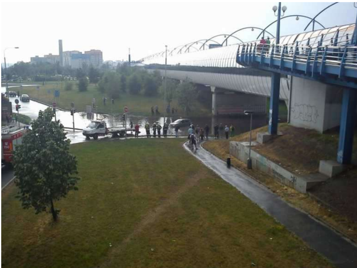
Obr. č. 4-7 Zatopený podjezd v ul. Ocelkova (foto George Sarichev, červen 2011)
