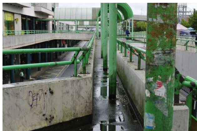
Podhled zastřešující lávky
