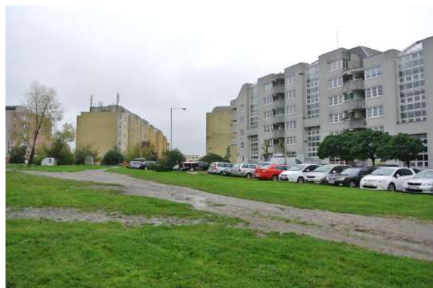
Neudržovatelné a nevyužitelné prostory parkoviště
