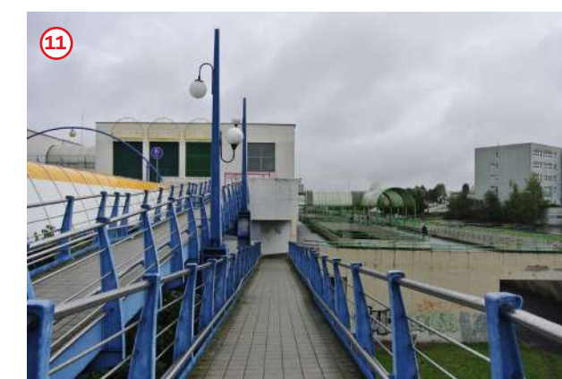
Rampa vedoucí na tubus metra
