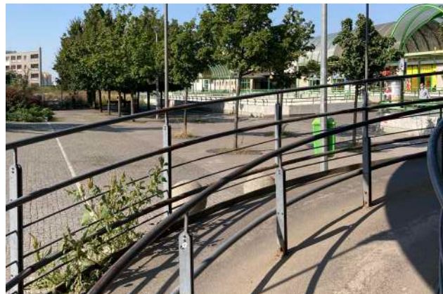
Chodník vedoucí od západní části nástupišť k ul. Ocelkové
